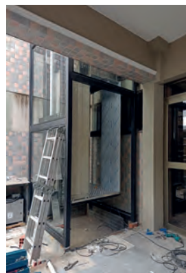
Obra da instalação do elevador
